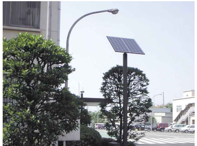
ソーラー発電による照明(鶴見工場)
