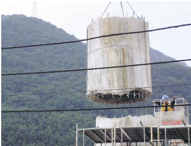
ボイラー煙突の撤去(日清ファルマ上田工場)
