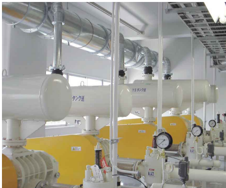
三葉式ルーツブロウ (日清製粉鶴見工場)
