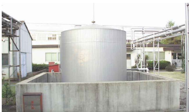
防油堤(日清製粉グループ上福岡研究所群)
