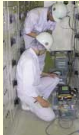
現場での測定(東灘工場)
