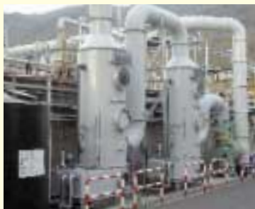
排水処理脱臭装置
