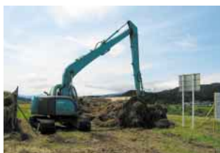
河川敷刈草コンポスト化工事の仕込み
