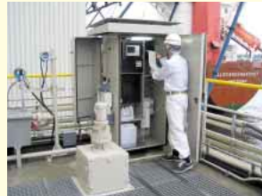
設備に頼るだけでなく、日々の監視等の作業も実施
