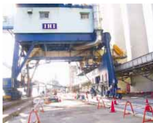
液状化対策工事 (鶴見工場)
