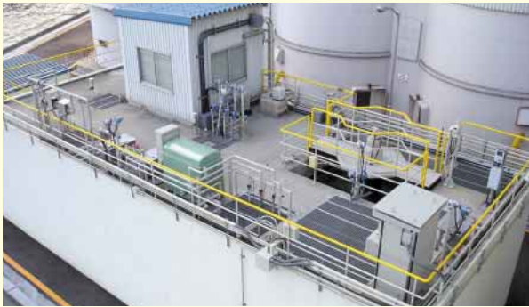
改修された廃水処理設備（鶴見工場）
