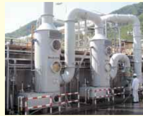
脱臭装置（日清ファルマ上田工場）
