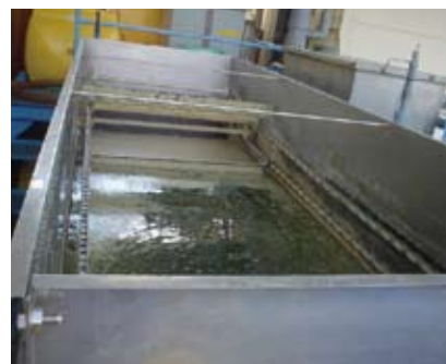
■イニシオフーズ工場の排水設備(加圧浮上装置)
