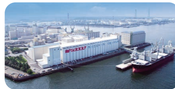
日清製粉知多工場新ラインの増設(2015年5月稼働)
