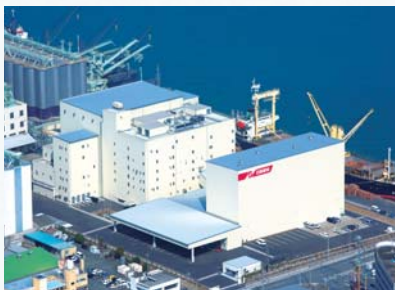
福岡工場の外観 (手前:自動倉庫棟、奥:製造棟)
