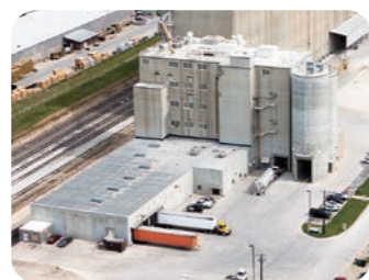
新ライン増設に着手 (ミラーリングカンパニーLLC サジー工場)
