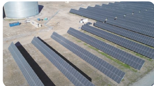
大規模な太陽光発電を導入した製粉工場。使用電力の約15%が再生可能エネルギーから供給されています。(ミラー・ミリング・カンパニー・LLCフレズノ工場)
