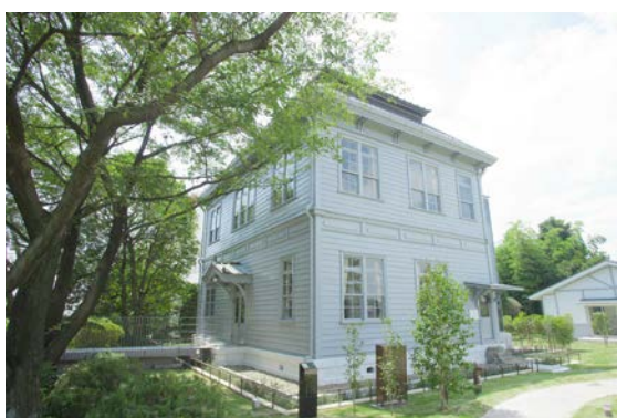
製粉ミュージアム本館
