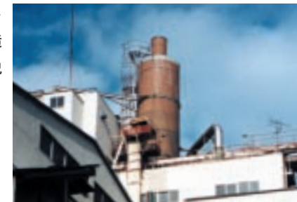
臭気脱臭装置(鶴見工場ペットフード部)
