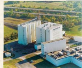
Miller Milling Company ウィンチェスター工場
