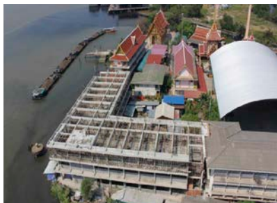
工場に隣接する小学校兼寺院の 校舎拡張工事の様子 日清製粉STC(タイ),日清テクノミック(タイ)
