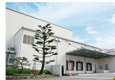
マ・マーマカロニ神戸冷凍食品新工場(2015年5月稼働)
